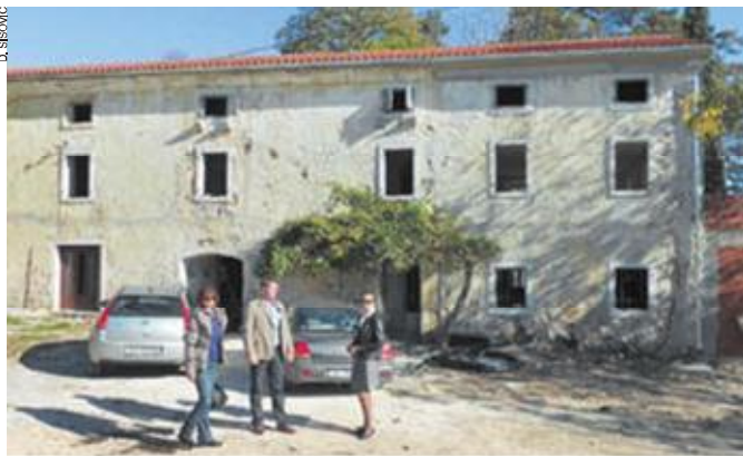
U prizemlju zgrade na Gortanovom brijegu uređuje se didaktička kuhinja, a prvi kat i potkrovlje uredit će se kroz druge eurofondovske projekte
